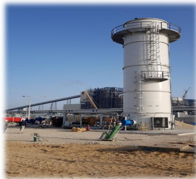
תמונה מס' 2: מערכת VCU למישוב אדי הדלק והפחתת פליטות בנזן ומטרדי ריחות
